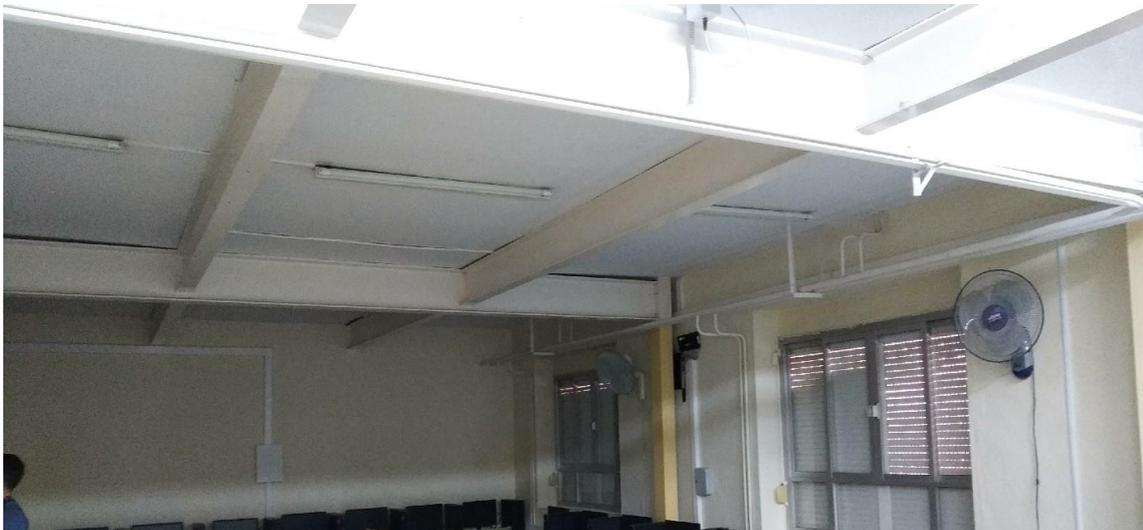
Imagen: Módulo A, entramado metálico de vigas del forjado unidireccional.
