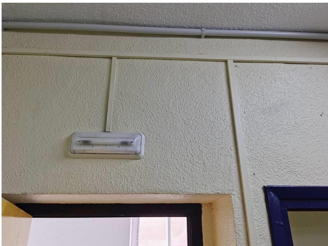
Fotografía 26. Luminaria de emergencia existente en aula de módulo A.
