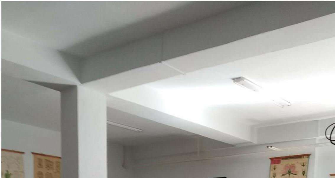
Imagen: Módulo B, vigas de hormigón armado descolgadas.
