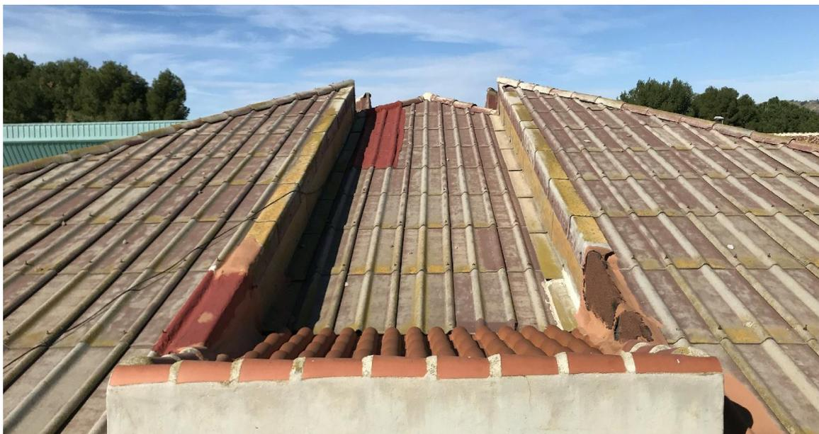
Imagen: Módulo C, cubierta de fibrocemento del edificio original.
